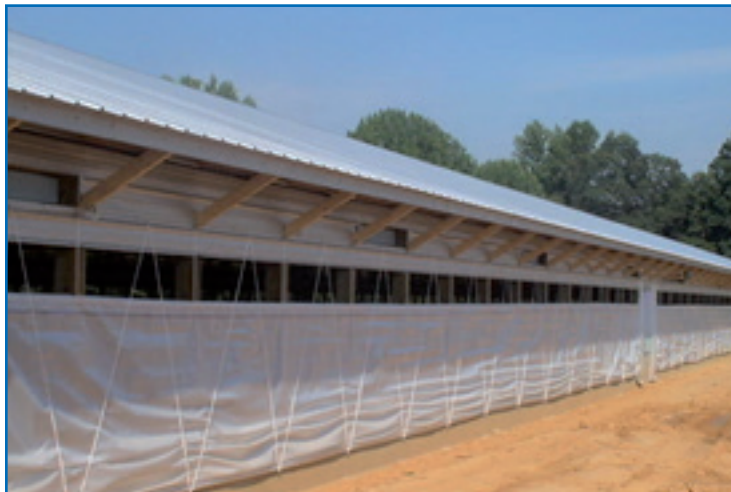
図3: 舎内への熱の負担を減らすために白く塗られた屋根の一例
